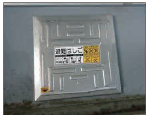
5 上枠の回りにシーリングをし、工事完了です。
