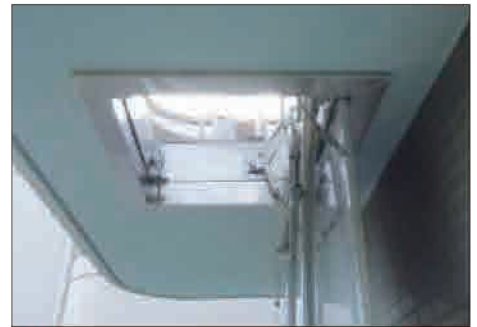
3 新しいハッチの枠・はしごを取付けます。
