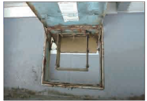
1 既設ハッチの撤去は、下階等への腐食粉塵飛散に注意し行います。
