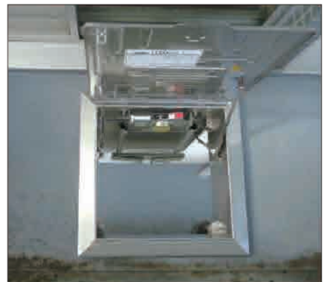
4 ハッチの開閉、付帯部品の調整・点検を行います。
