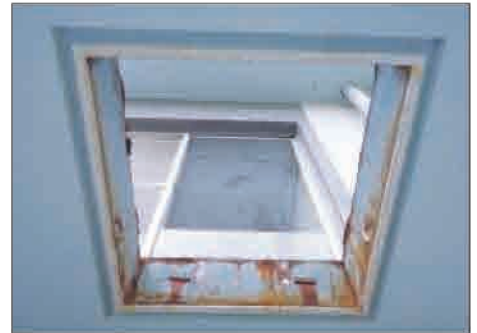
2 既設ハッチの中枠のみを残し、上下の蓋・はしごなどは全て取り外します。(建物の強度を損なうため、ハツリ工事は行いません。)
