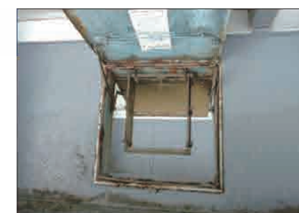
1 既設ハッチの撤去は、下階等への腐食粉塵飛散に注意を行います。
