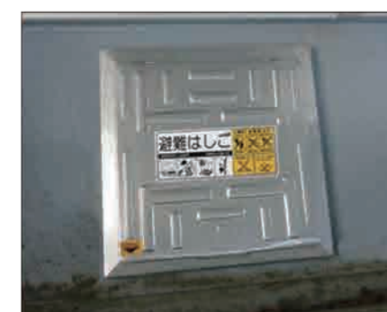
5 上枠の回りにシーリングをし、工事完了です。
