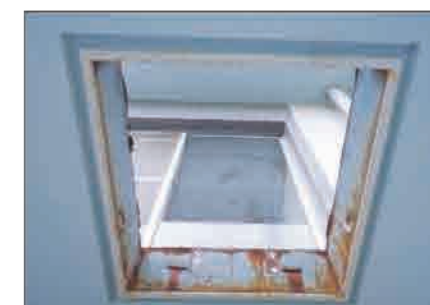
2 既設ハッチの中枠のみを残し、上下の蓋・はしごなどは全て取り外します。(建物の強度を損なうため、ハッチ工事は行いません。)
