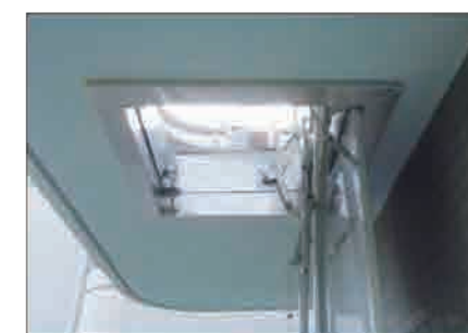
3 新しいハッチの枠・はしごを取付けます。
