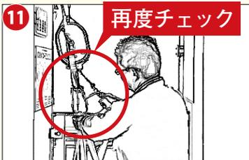
11 緩降機着用具(緊結部分)と結合用フック(小)と結合用フック(大)が必ず接続されているか再確認
